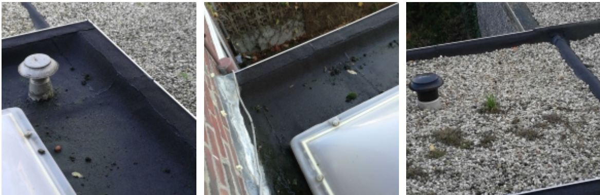
Dakbedekking vlak, bitumineus
